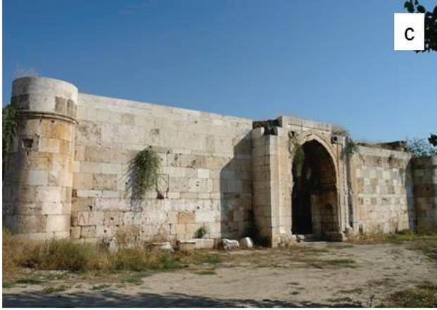
Şekil 2: Antik dönem yapılarında traverten kullanımına örnekler. a) Pamukkale, b) Laodikeia, c) Akhan - Selçuklu kervansarayı, d) Çardak Han - Selçuklu kervansarayı. Akhan ve Çardak kervansaraylarının fotoğrafları Mustafa Beyazıt tarafından sağlanmıştır.
